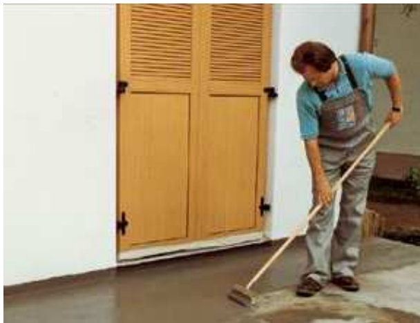
Густо нанести первый слой PCI® Seccoral 2K при помощи щётки на основание.
