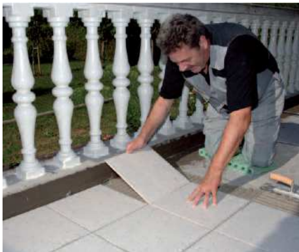
Быстрая и надежная укладка керамической плитки на балконах и террасах с помощью PCI® Rapidflott
