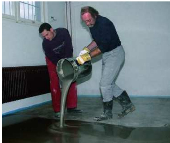
Простое и легкое выравнивание горизонтальных поверхностей с помощью PCI ® Periplan
