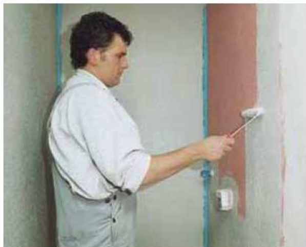
Нанесение неразбавленного PCI® Lastogum на основание с помощью валика.
