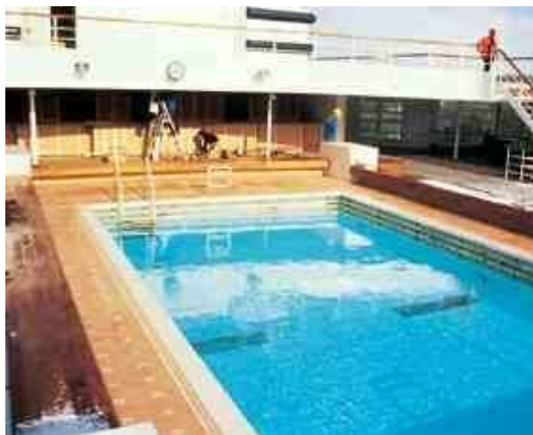
Керамическое покрытие на корабле, уложенное при помощи PCI Collastic.
