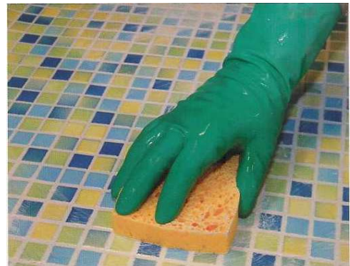
Промывка керамического покрытия при помощи мягкой губки PCI® Epxi-Schwamm fein
