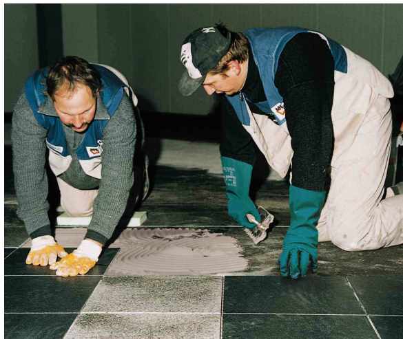
Надежная укладка плит из натурального камня средним слоем с помощью PCI® Carrament.
