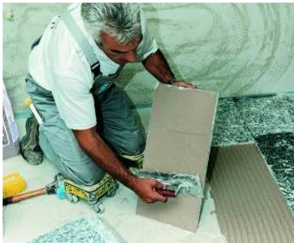
Для беспустотной укладки всегда наносите необходимый слой клея на обратную сторону плиты.
