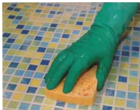
Промывка мозаики при помощи губки
